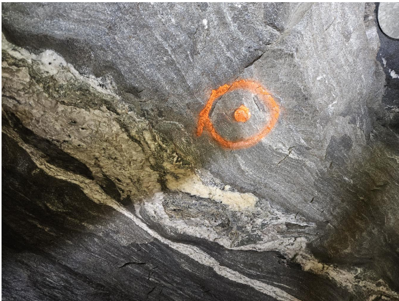
Foto 11. Pel 8204. Bom i berg. Det er anvist 2,4 m lang bolt Ø20 mm.
