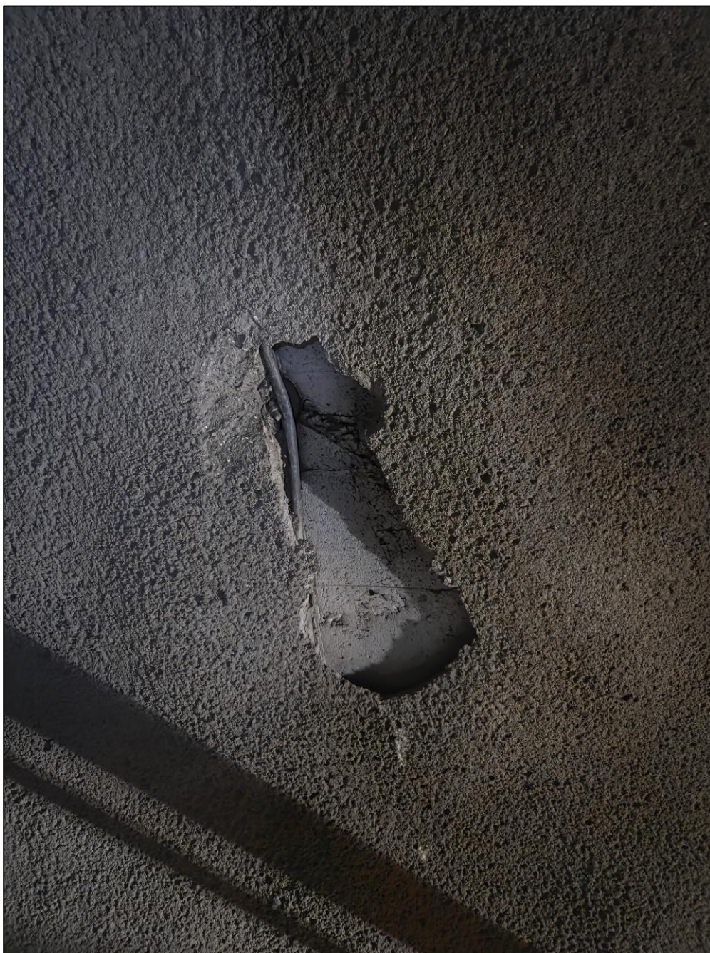
Foto 3. Pel 560. Skade på vann- og frostsikring. For å redusere brannfare anbefales det å tette hullet med sprøytebetong.
