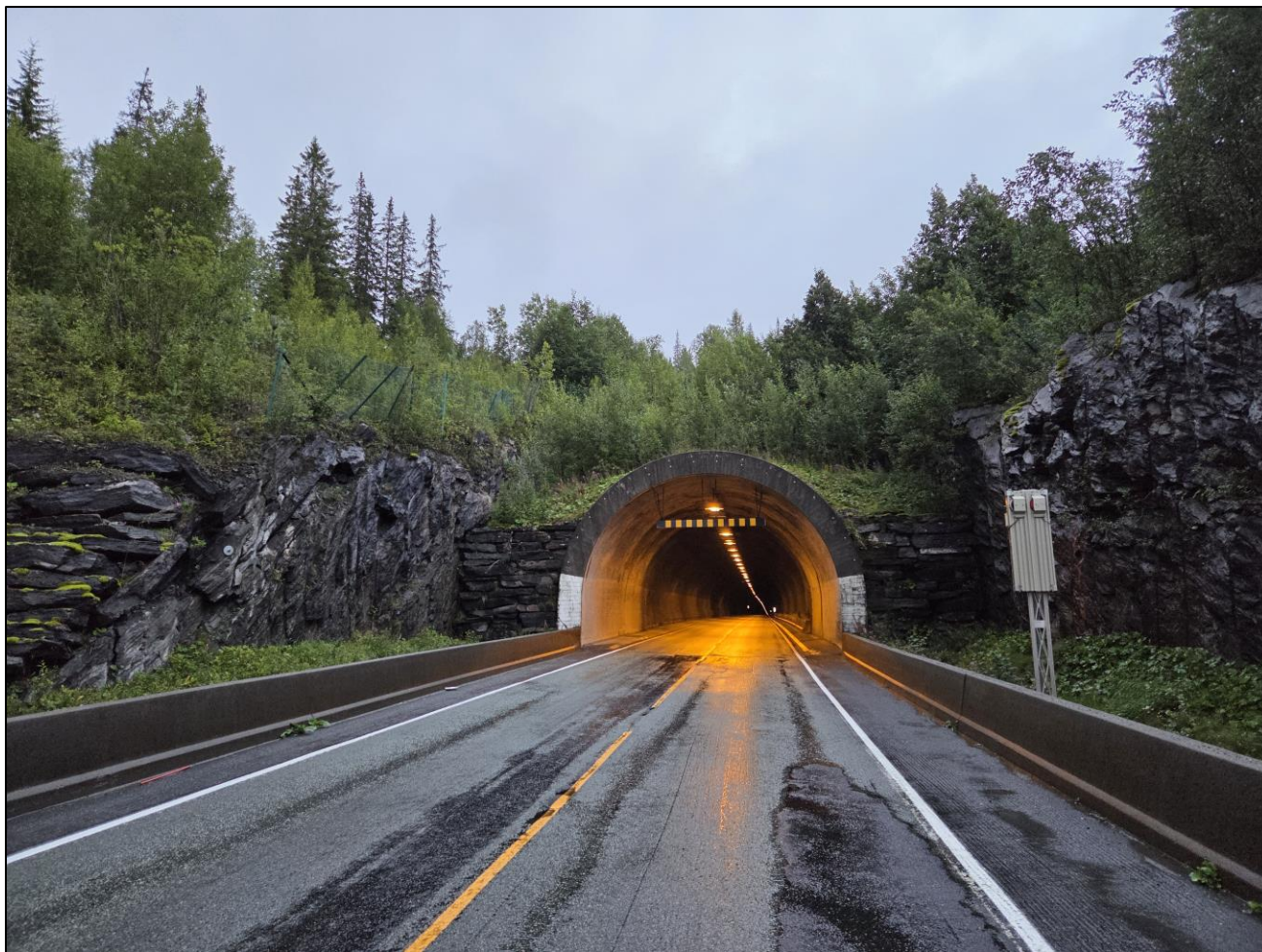
Foto 1. Oversikt forskjæring og tunnelportal sørvest. Forskjæringen til portalområdet er sikret med noen spredte bolter. Det er benyttet flettverksgjerde for vegetasjonen langs forskjæringen.
