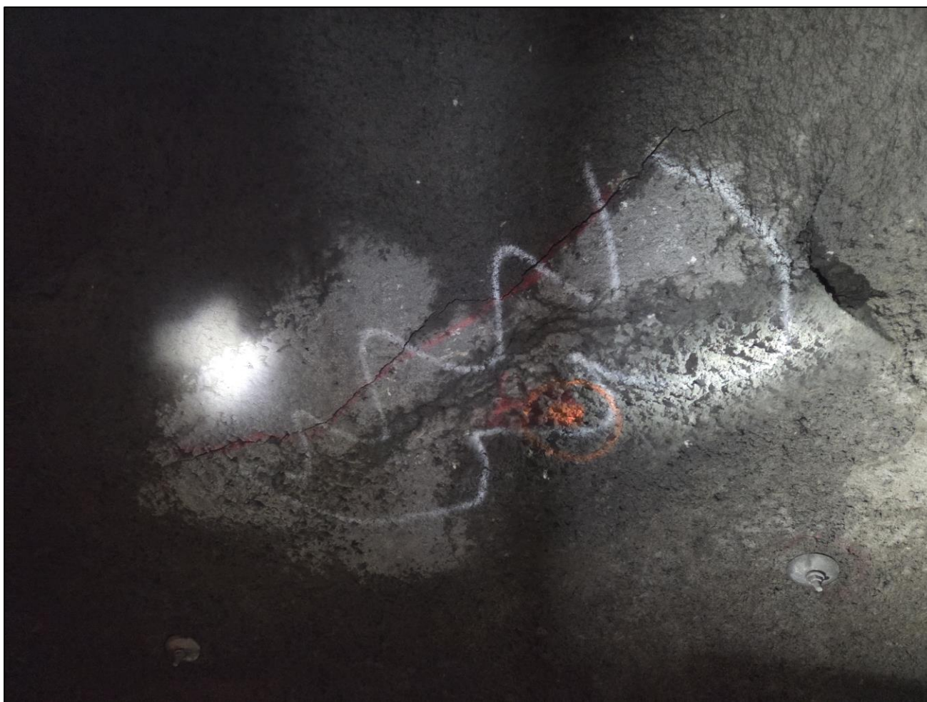
Foto 10. Pel 6715. Sprekk og bom i sprøytebetong. Det er anvist 2,4 m lang bolt Ø20 mm. NB: anvist sikring fra og med pel 5705 til pel 8620 ble det brukt oransje merkespray.
