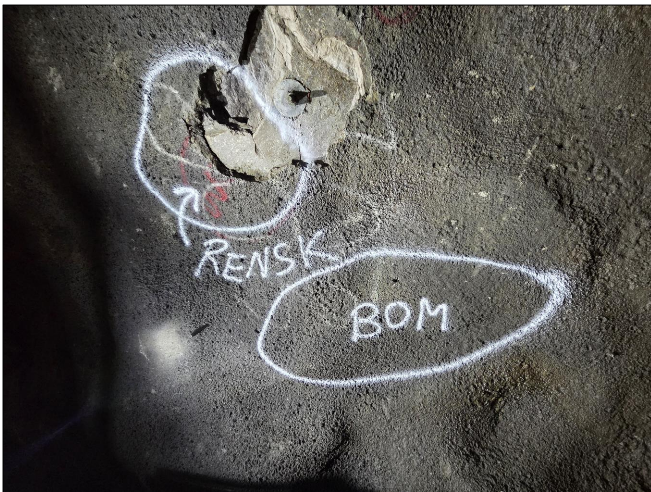
Foto 6. Pel 3960. Bom og avskalling av sprøytebetong. Det er nødvendig med rensk i området med avskallet sprøytebetong.
