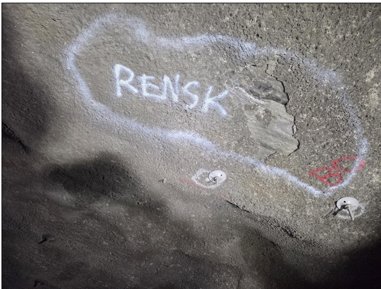
Foto 5. Pel 3310. Avskalling av sprøytebetong. Det er nødvendig med rensk av området innen 1-2 år.
