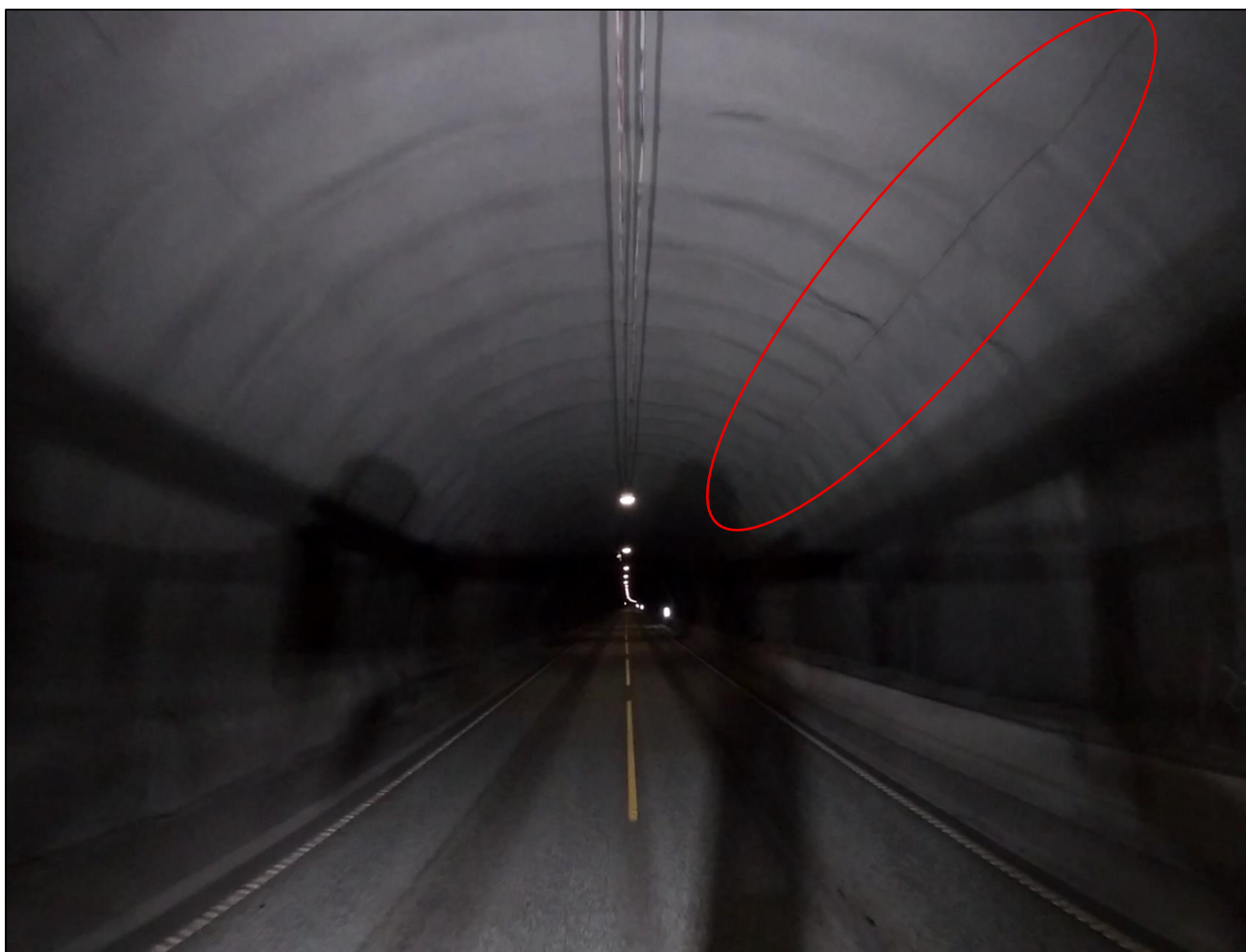
Foto 4. Pel 2345-2400. Lang sprekk i brannsikret PE-skum. Det anbefales å tette/fuge sprekken.
