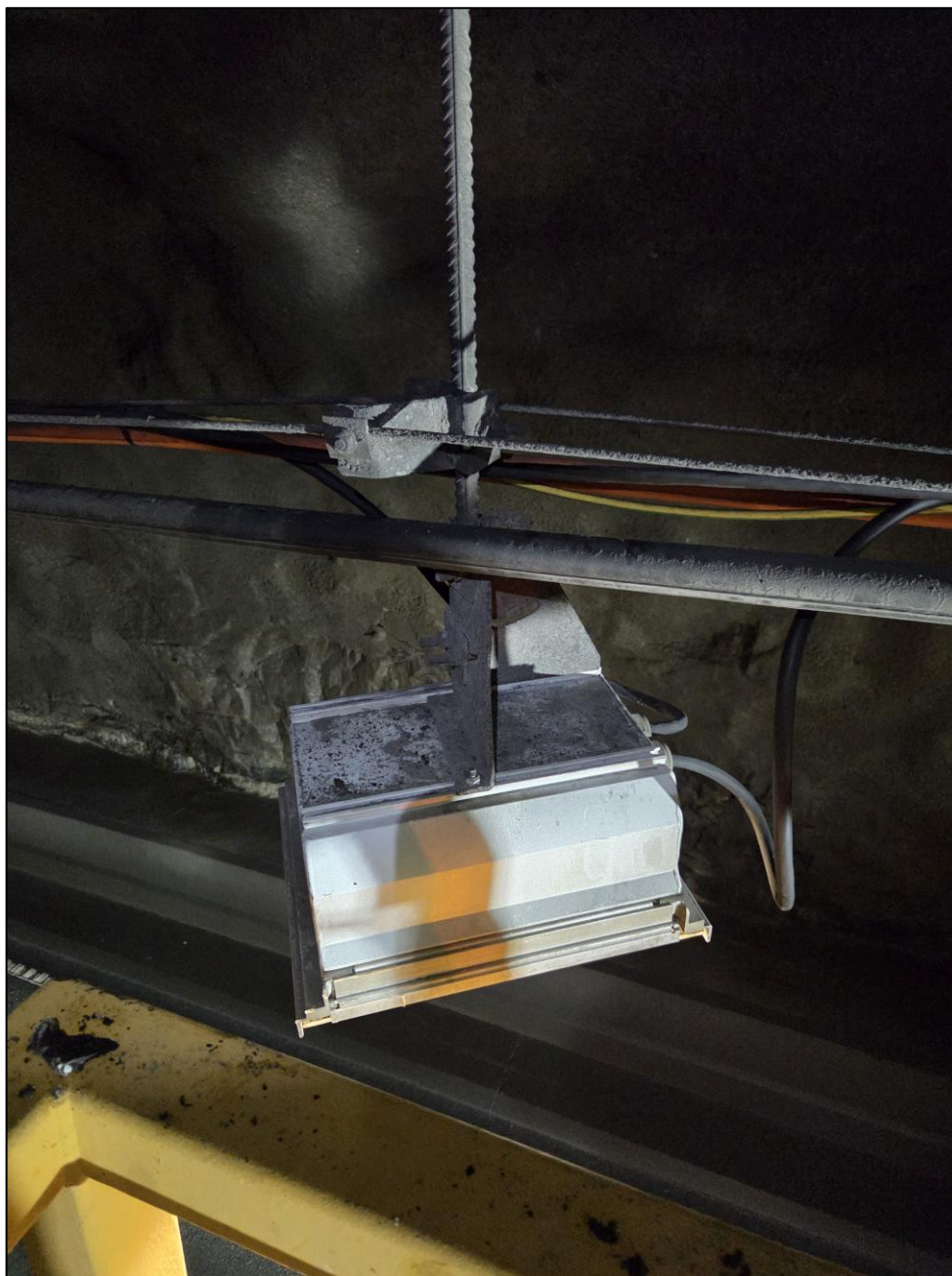
Foto 8. Pel 4890. Lykt ble påkjørt av lift. Lykten henger tilsynelatende godt, men lykten bør sjekkes.
