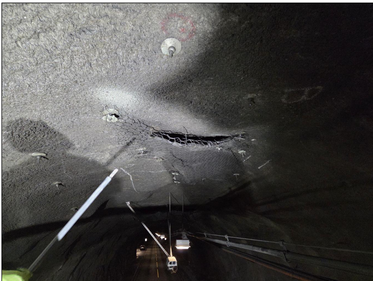
Foto 9. Pel 5694-5702. Duk med flettverksnett, festet med bolter. Bør vurderes om området skal innsprøytes med sprøytebetong for vann- og frostsikring.
