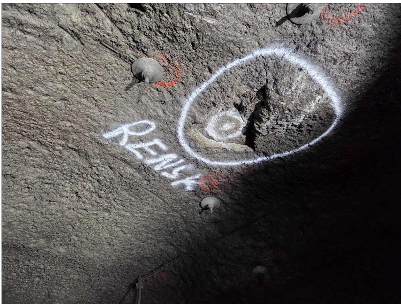
Foto 7. Pel 4345. Avskalling av sprøytebetong. Det anbefales rensk. Det er anvist 2,4 m lang bolt Ø20 mm.
